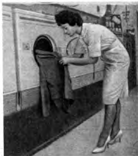
Р и с. 164. В этой автоматизированной установке для сухой химчистки одежды в качестве растворителя используется перхлорэтилен.
