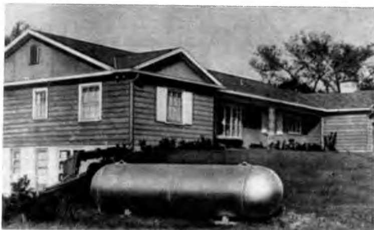
Р и с. 169. Типичный способ использования баллоного газа в районах, не получающих природного газа по газопроводам.
