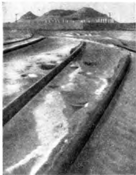
Р и с. 166. По этому нефтепроводу нефть транспортируется через пески Ближнего Востока. Трубопроводы аналогичного типа используются для доставки природного газа от месторождений к погребителям.
